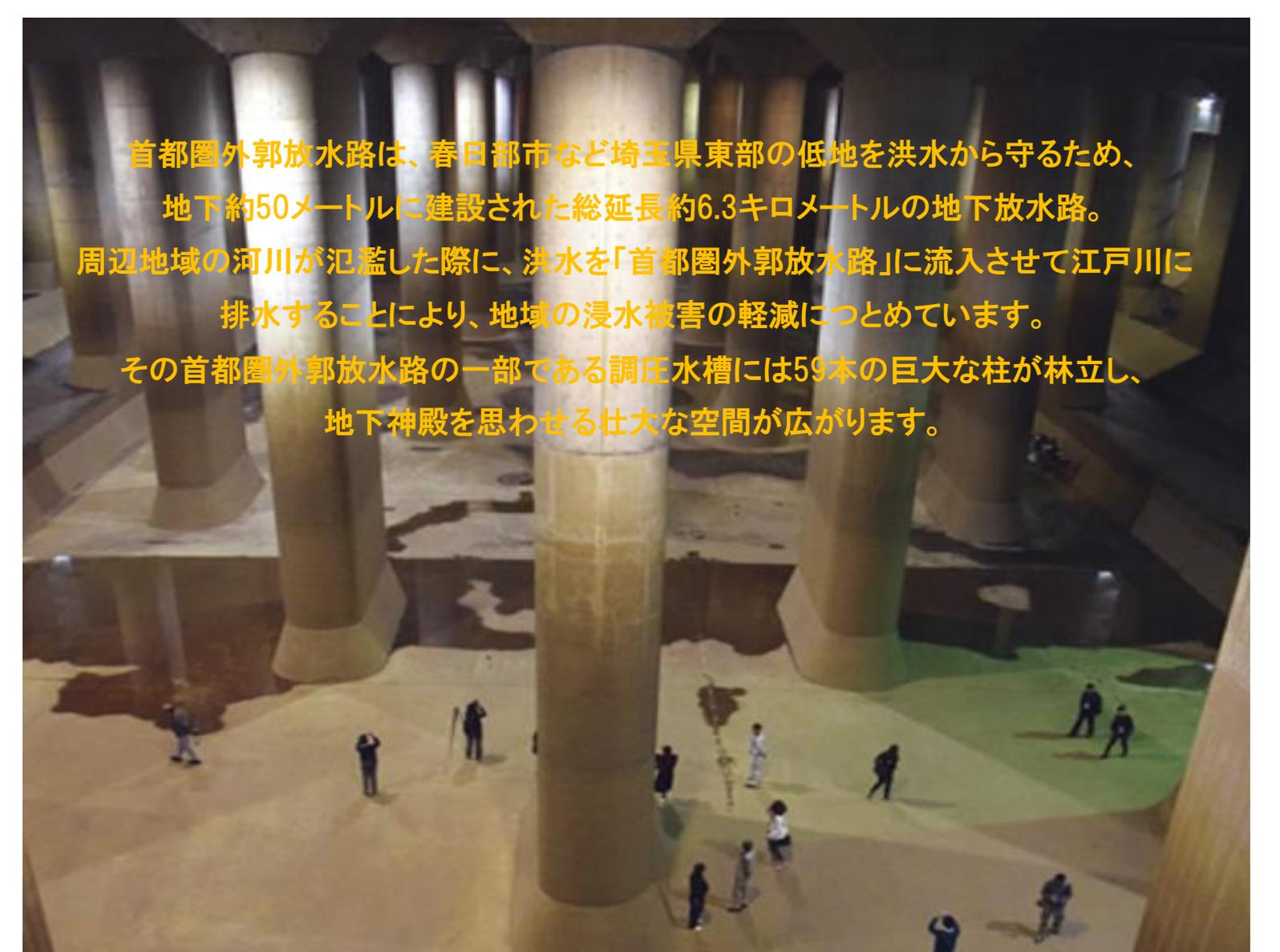
首都圏外郭放水路は、春日部市など埼玉県東部の低地を洪水から守るため、地下約50メートルに建設された総延長約6.3キロメートルの地下放水路。周辺地域の河川が氾濫した際に、洪水を「首都圏外郭放水路」に流入させて江戸川に排水することにより、地域の浸水被害の軽減につとめています。その首都圏外郭放水路の一部である調圧水槽には59本の巨大な柱が林立し、地下神殿を思わせる壮大な空間が広がります。
